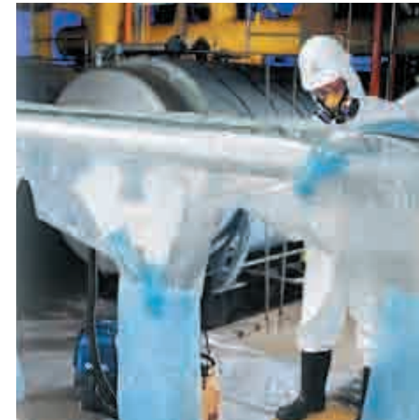
グローブバッグ方式による石綿除去は左の手順で行ってください。
